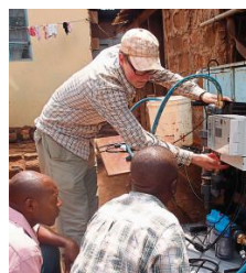
Deutsche Ingenieure leiten den Bau der Anlagen an.
